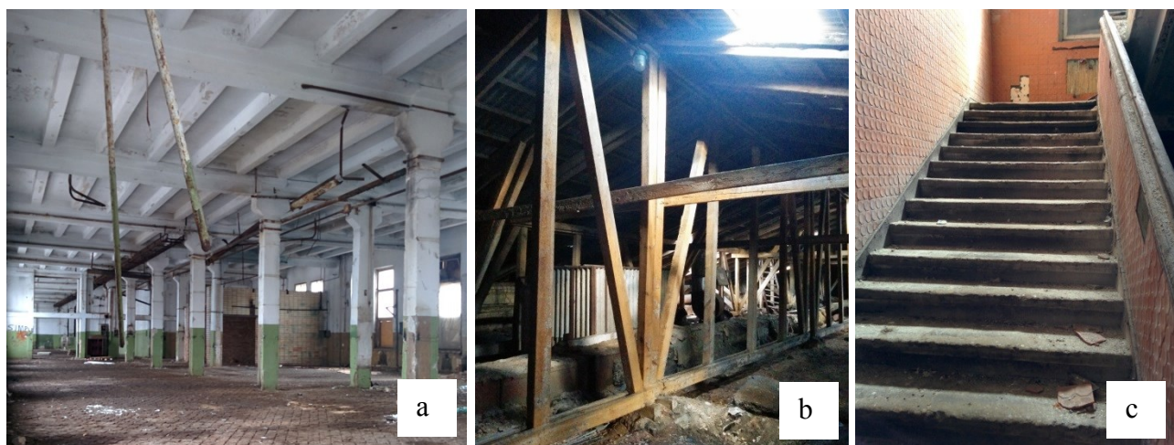
3.17 pav. Pagrindinio gamyklos pastato konstrukcijos: a) triaukštės pastato dalies gelžbetoninis karkasas; b) stogo konstrukcijos; c) laiptinė
