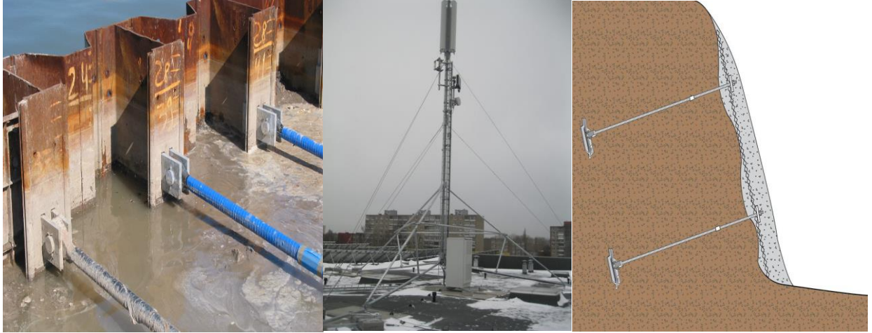
5 pav. Iš kairės į dešinę – Spraustasienė su inkarais, telekomunikacijų antena su atotampomis (gijomis), nuošliaužų apsauga įrengiant atraminę sieną su inkarais (Architectural structural tie bars 2015)
