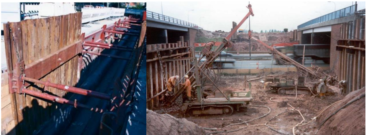
6 pav. Iš kairės į dešinę - laikinas konstrukcijų montavimo darbo vietos sienos ankeravimas, iškasų sienos parėmimas plienine sienute su ankeriais (Architectural structural tie bars 2015)
