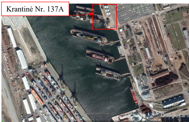
20 pav. Krantinės 137A, 138A ir 139 (dalies) vaizdas iš viršaus užfiksuotas 2014-03-28
