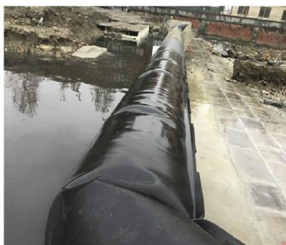
14 pav. Pripučiama kontrolės užtvanka (Comino et al. 2019)
