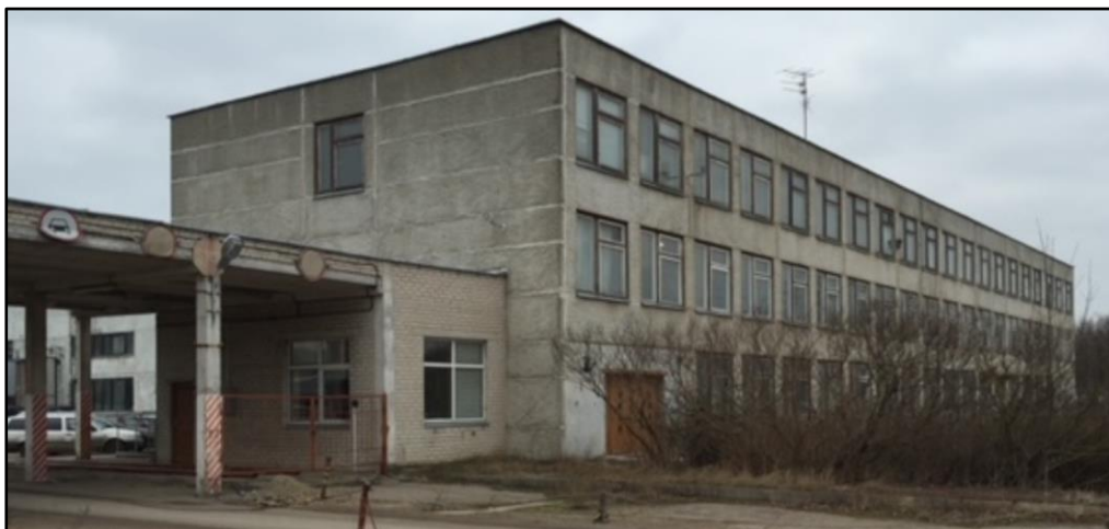
14 pav. Pastatas prieš renovaciją (nuotr. autoriaus)
