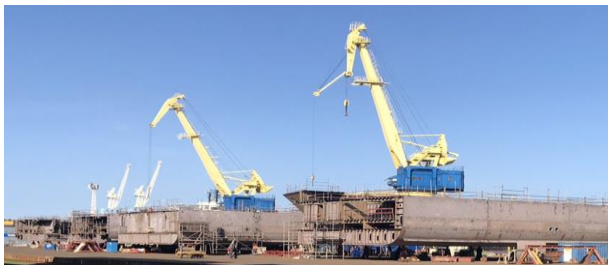
Fig. 2 Shipbuilding open site
